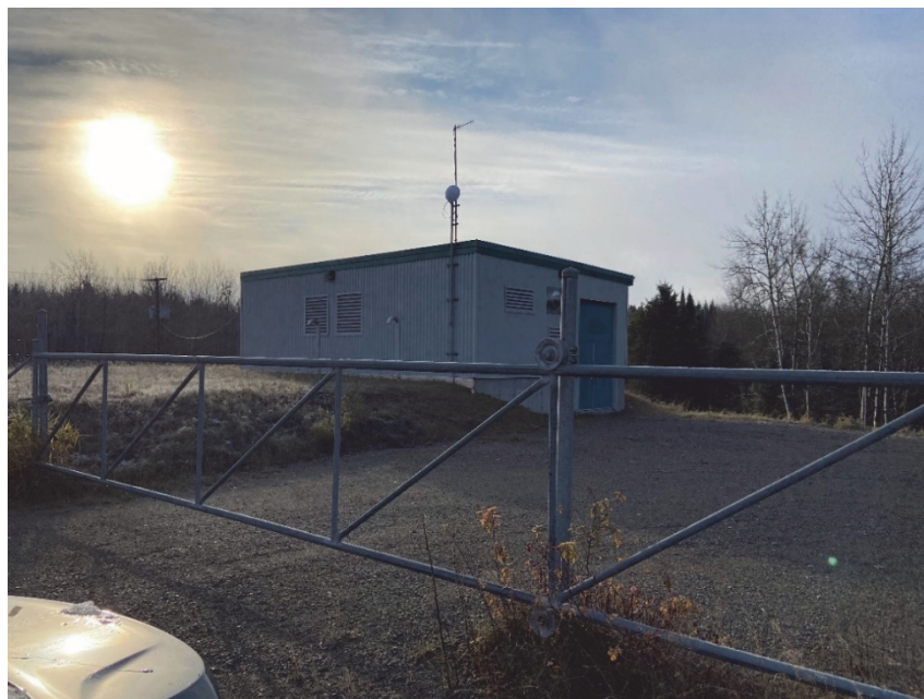
Photo 4 : Aperçu du bâtiment de production d'eau potable – 2020-01-19
