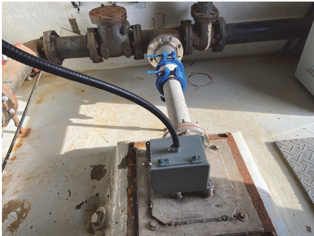
Photo 2 : Aperçu du puits PP-2/63 - 2020-10-19
