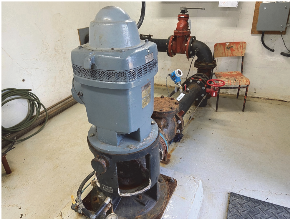
Photo 1 : Aperçu du puits PP-1/52 - 2020-10-19
