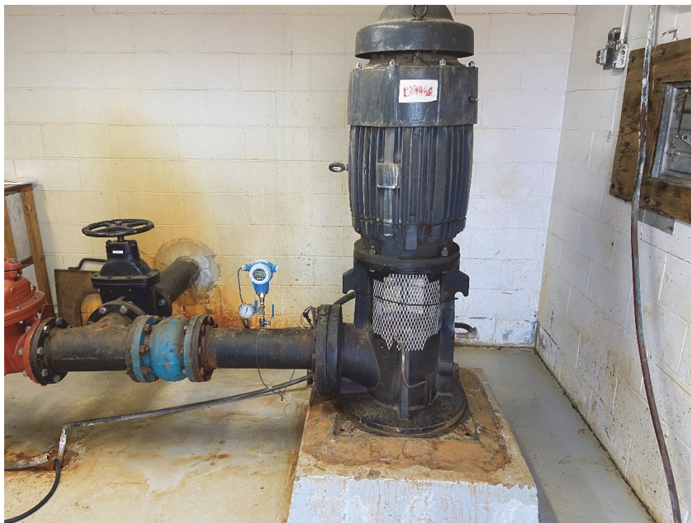
Photo 3 : Aperçu du puits PP-3/81 - 2020-10-19
